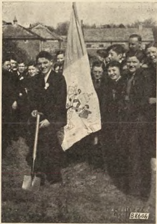
Shrigley (Inghilterra). — Il primo colpo di vanga per le fondamenta della nuova chiesa a S. Giov. Bosco.
